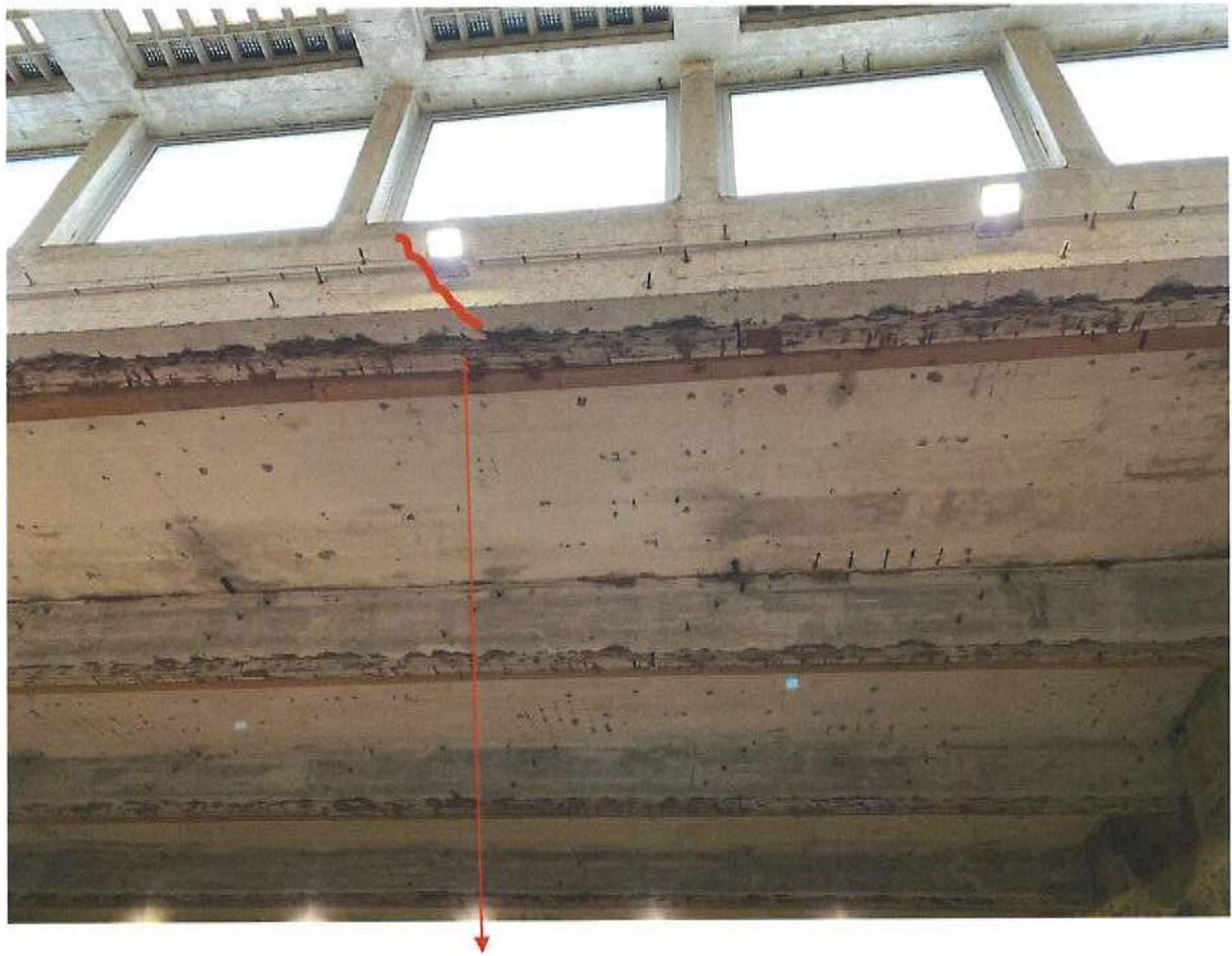
Fissure en intrados de poutre échelle
