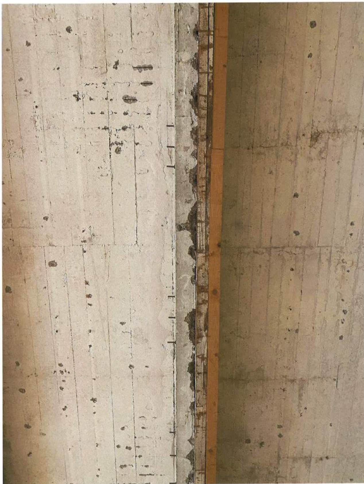
Eclatement du béton dû aux impacts de balles
