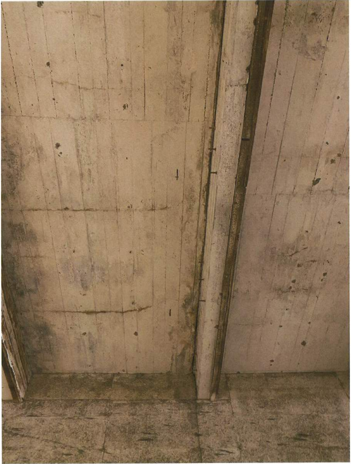
Fissuration en sous face de dalle, défaut d'enrobage
