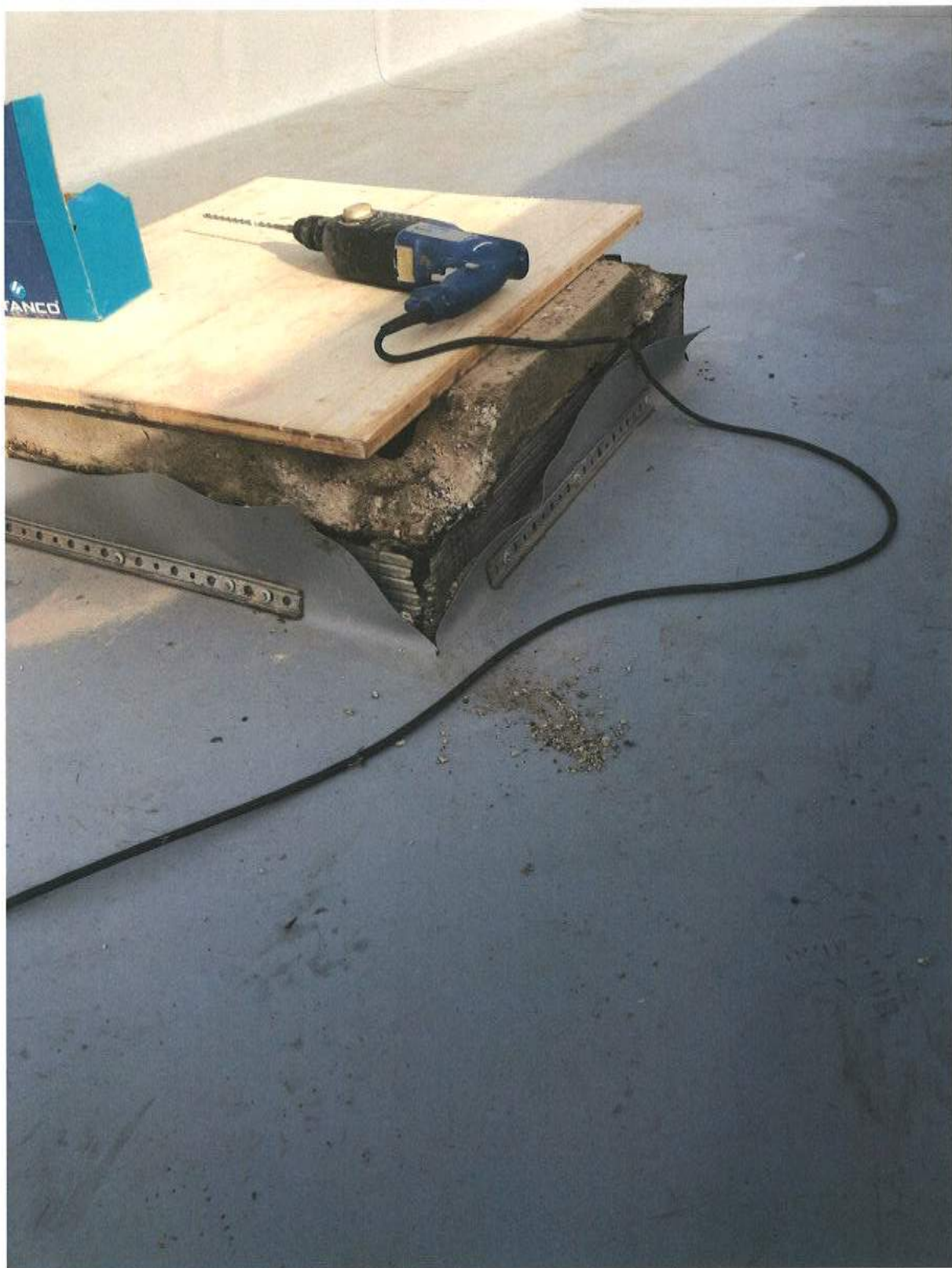
Relevé d'étanchéité à réparer
