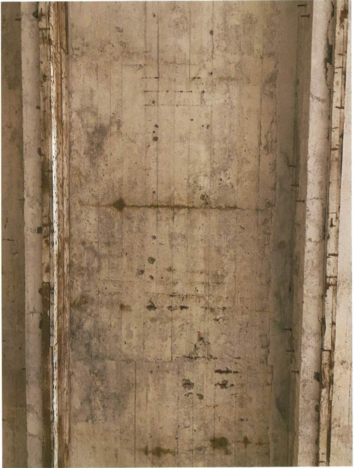
Fissuration en sous face, défaut d'enrobage
