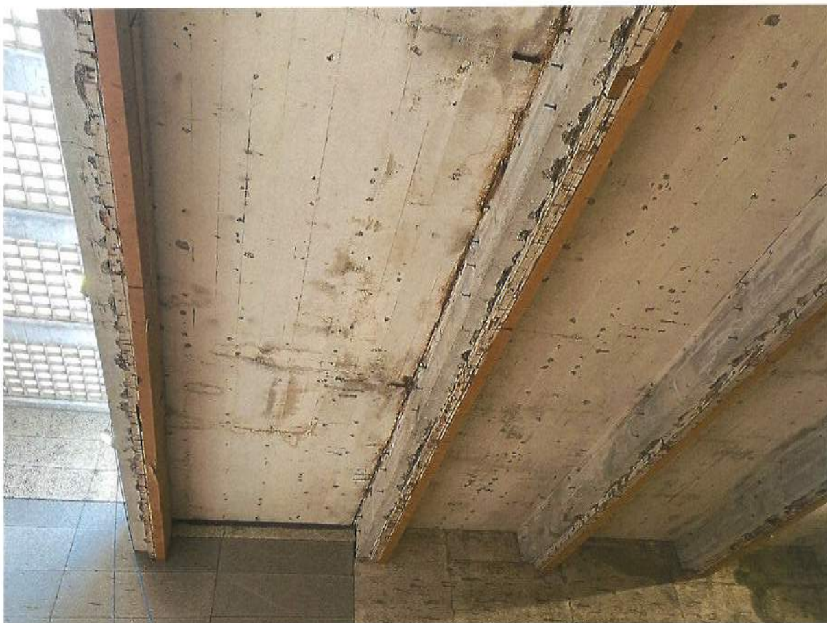
Joint de dilatation et sous face avec éclatements dus a un défaut d'enrobage
