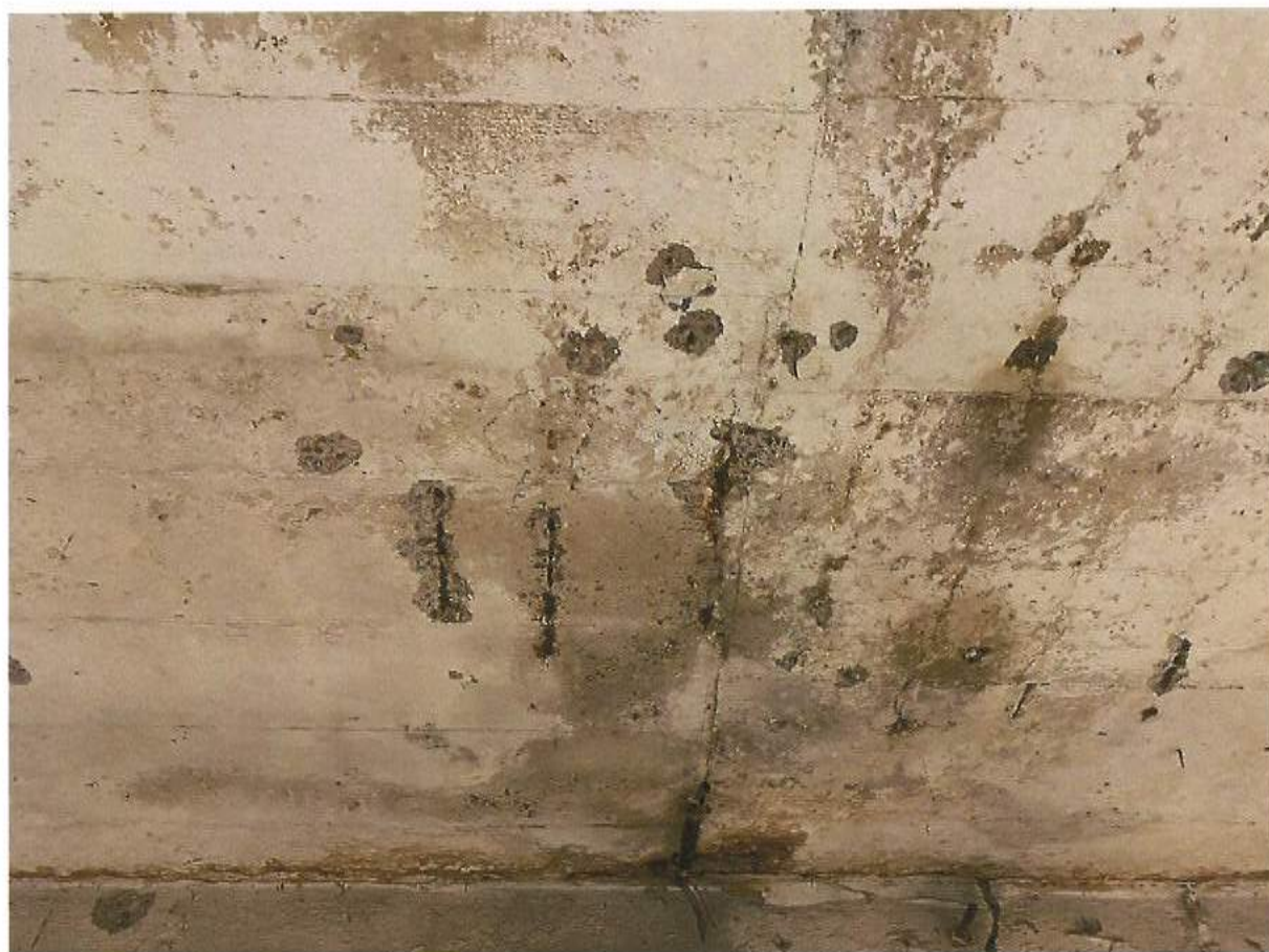
Sous face de dalle défaut d'enrobage
