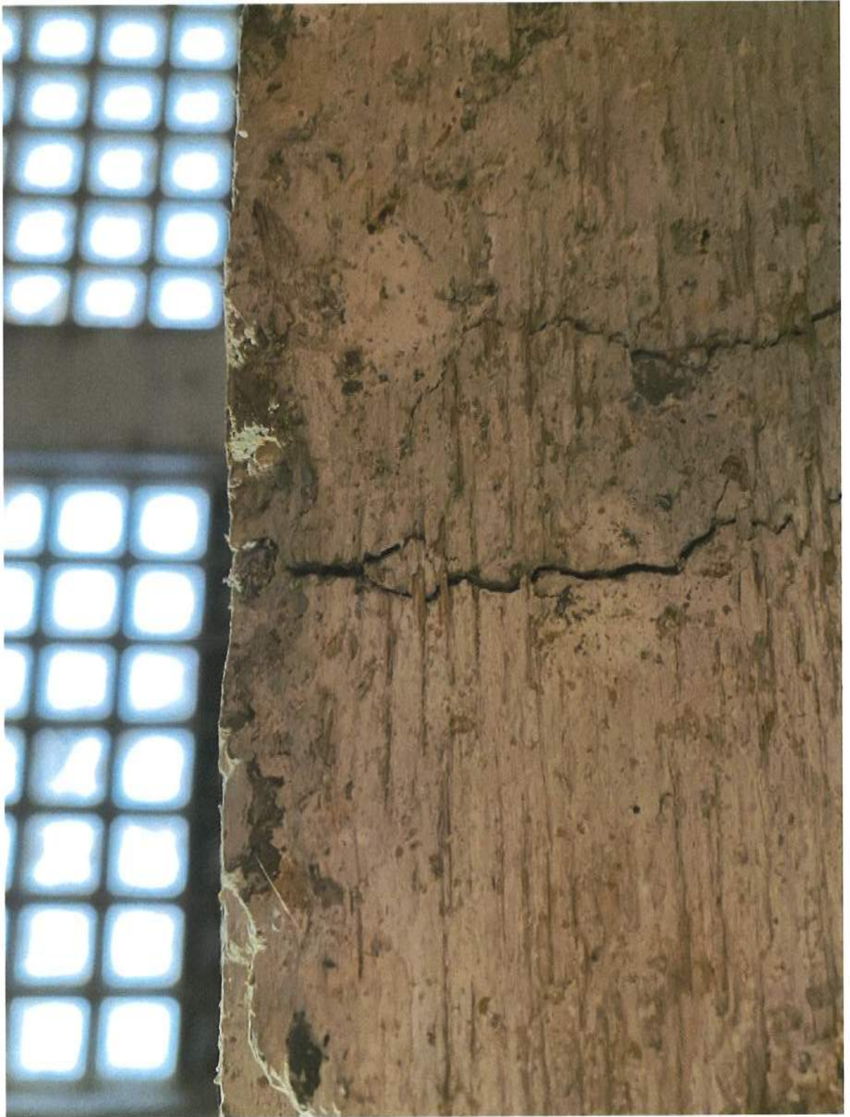
Poutre fissurée
