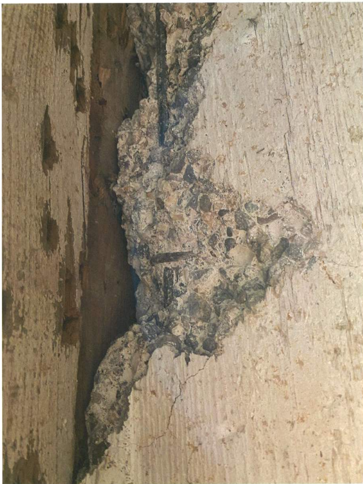
Eclatement du béton dû aux impacts de balles côté butte de tir
